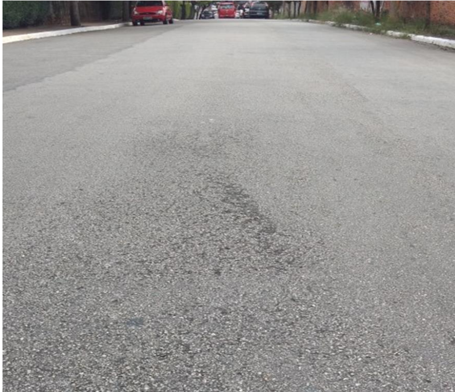
Figura 12 - Desgastes (Raveling). Fonte: Autor (2018)
