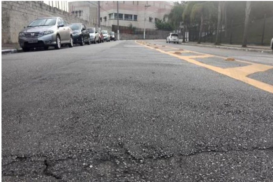
Figura 13 - Corruções (Shoving and Corrugation). Fonte: Autor (2018)
