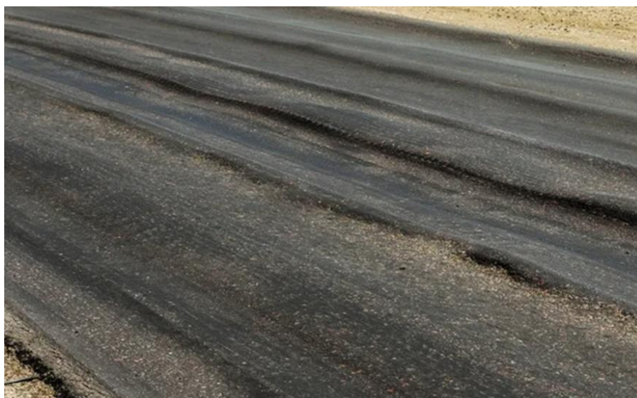
Figura 20 - Deformações ou Ondulações causadas pela passagem de veículos muito pesados e/ou uma má qualidade da base aplicada
