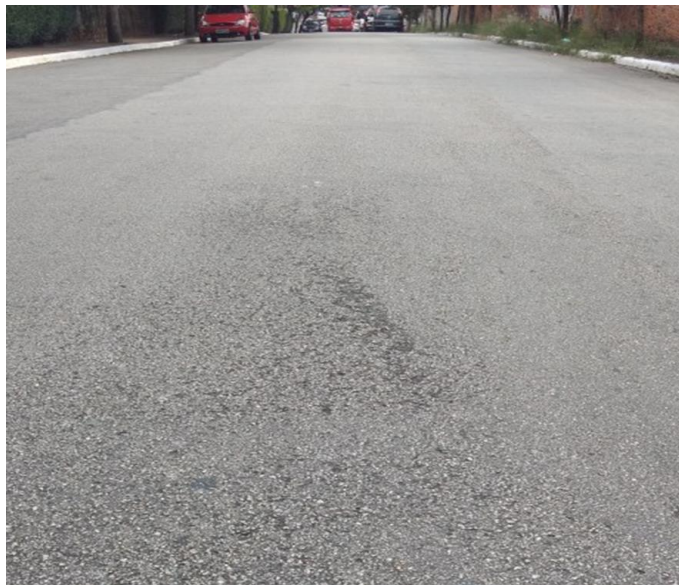
Figura 10 - Desgastes (Raveling). Fonte: Autor (2018)
