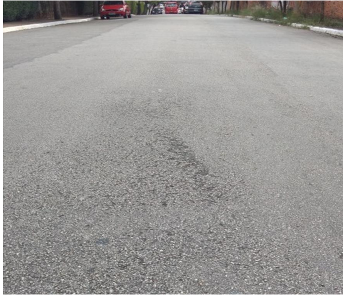
Figura 13 - Desgaste (Raveling). Fuente: Autor (2018)
