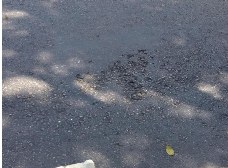
Figura 20 - Exudación (Bleeding). Fuente: Autor (2018)
