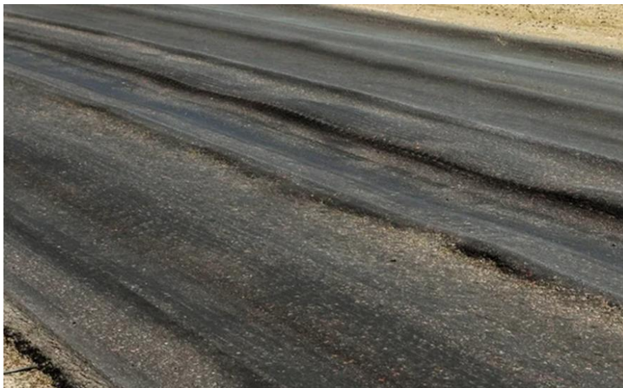
Figura 23 - Deformaciones u ondulaciones causadas por el paso de vehículos muy pesados y/o mala calidad de la base aplicada
