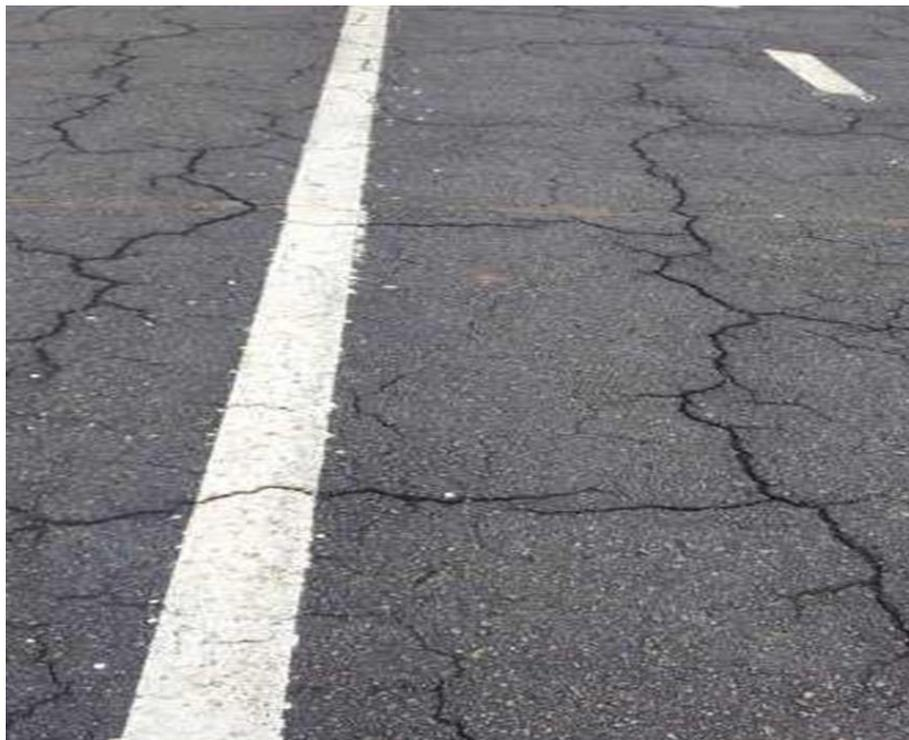
Figura 7 - Trincas de Bloco (block cracking). Fonte: Autor (2018)
