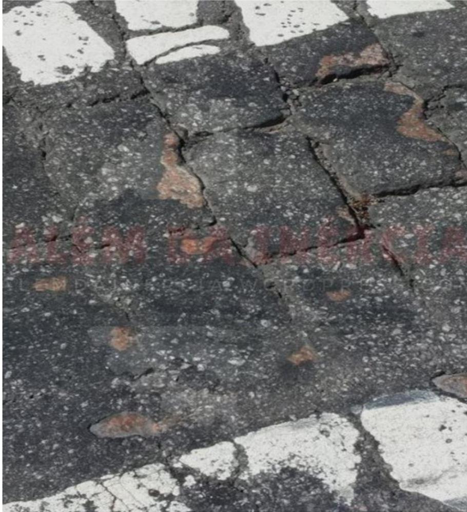
*Figura 13 - Trincas de Reflexão (Reflection Cracking). Fonte: Autor (2018)*
