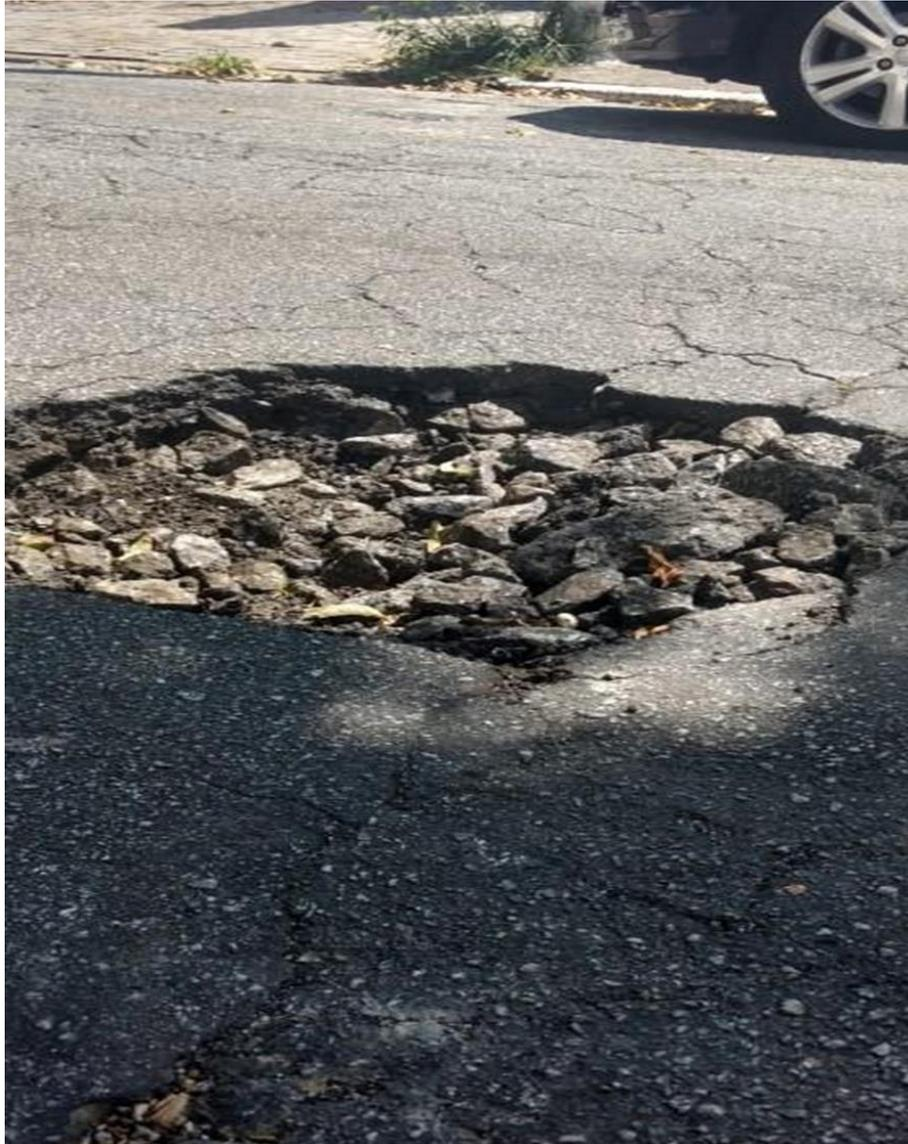
Figura 9 - Panelas (Potholes). Fonte: Autor (2018)
