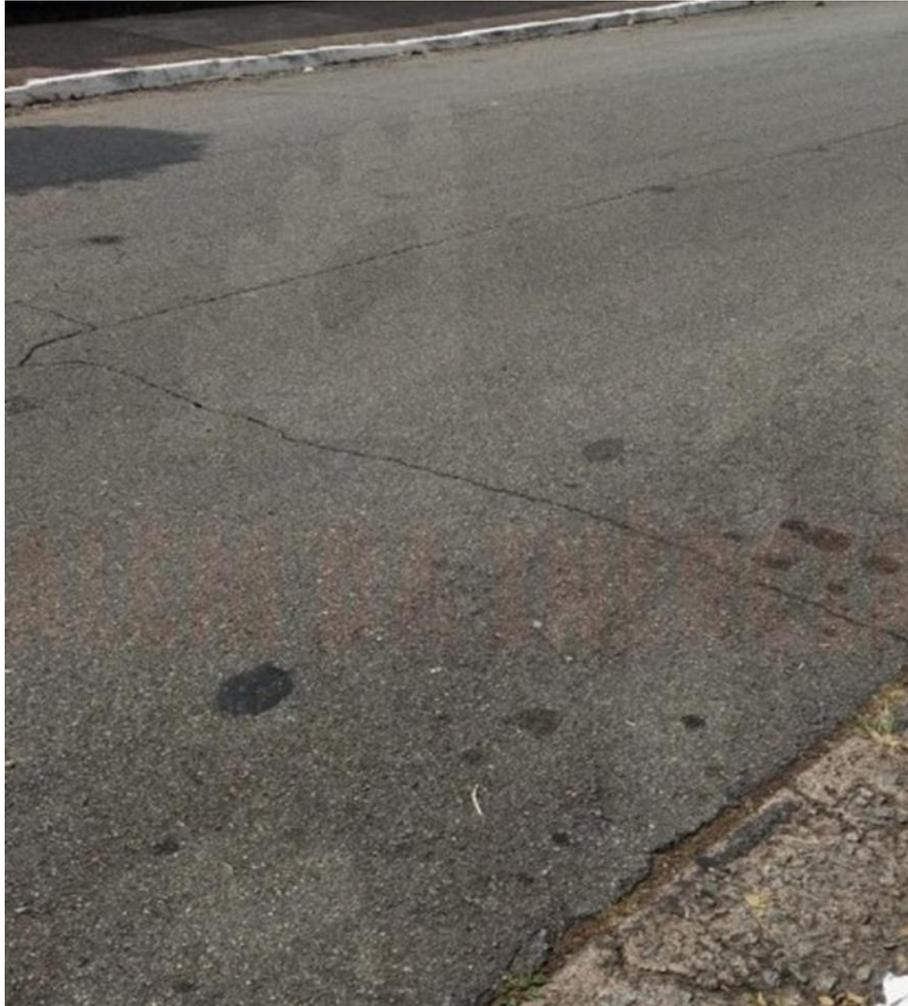
Figura 15 - Trinca Transversal (Transverse Cracking). Fonte: Autor (2018)
