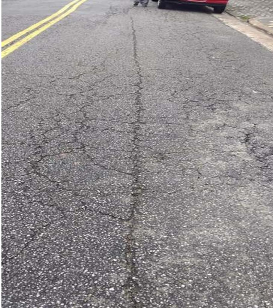
Figura 8 - Trinca Longitudinal (Longitudinal Cracking). Fonte: Autor (2017)
