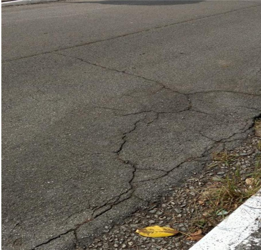
Figura 18 - Trincas de bordo (Edge Cracking). Fonte: Autor (2018)
