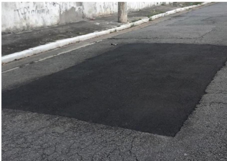
Figura 12 - Remendos (Patch). Fonte: Autor (2018)
