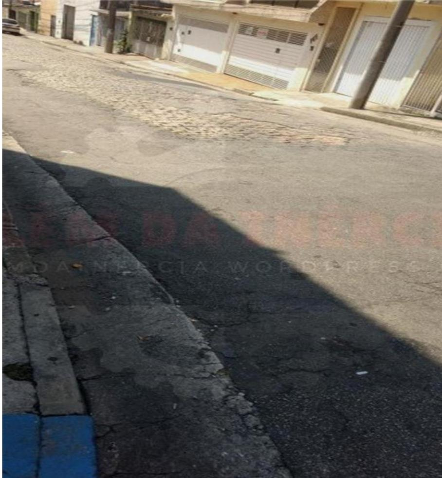
Figura 14 - Falta de Adesividade em Paralelepípedos. Fonte: Autor (2018)
