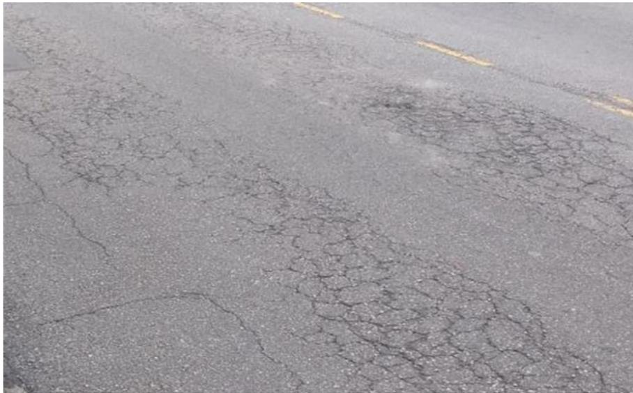
*Figura 6 - Deformação Permanente (Rutting) e Trincas de Fadiga (Fatigue Cracking) na trilha de roda.
