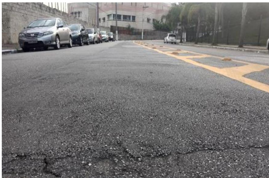
Figura 11 - Corrugaciones (Shoving y Corrugation). Fuente: Autor (2018)
