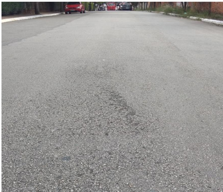
Figura 10 - Desgastes (Raveling). Fonte: Autor (2018)
