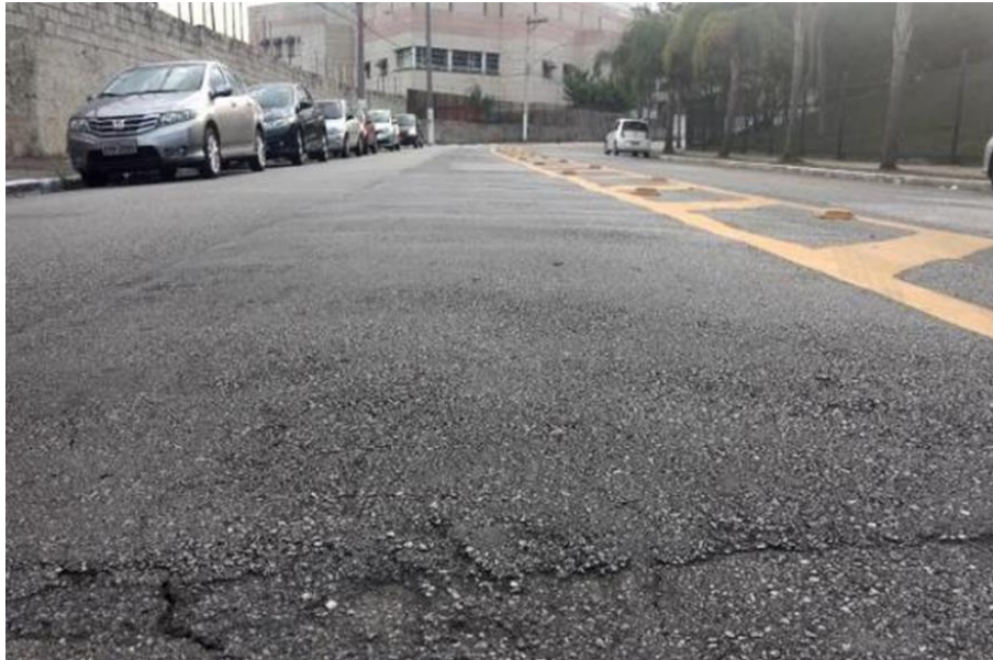
Figura 11 - Corrugações (Shoving and Corrugation). Fonte: Autor (2018)
