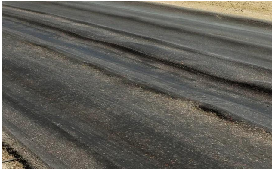
Figura 20 - Deformações ou Ondulações causadas pela passagem de veículos muito pesados e/ou uma má qualidade da base aplicada
