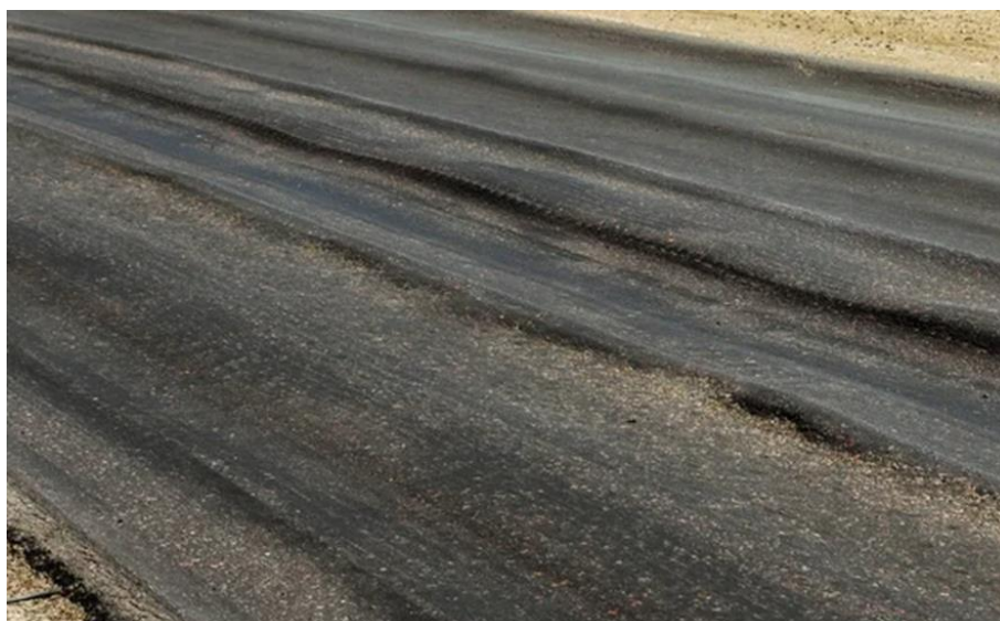
Figura 20 - Deformaciones u ondulaciones causadas por el paso de vehículos muy pesados y/o mala calidad de la base aplicada
